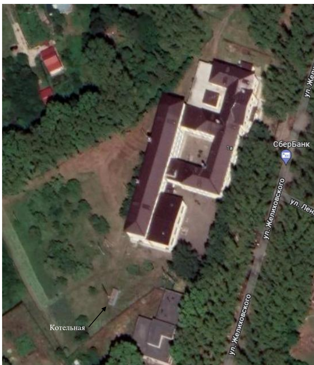
Котельная МБОУ СОШ им. Загоскина по адресу с. Рамзай, ул. Желиховского, д.1а
